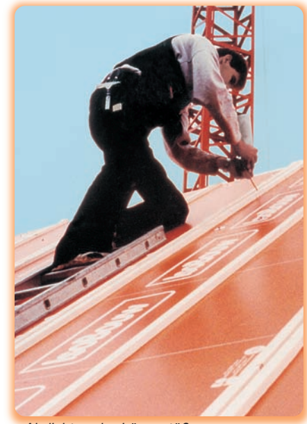
Abdichten der Längsstöße
