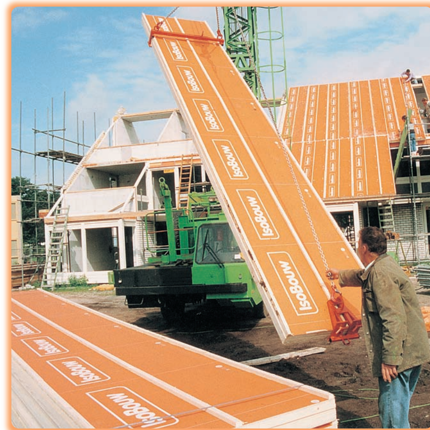
... schnell und sicher Verlegen mit dem IsoBouw Hebewerkzeug
