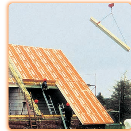
Bei großen Längen: Elementstoß auf der Mittelpfette ...
